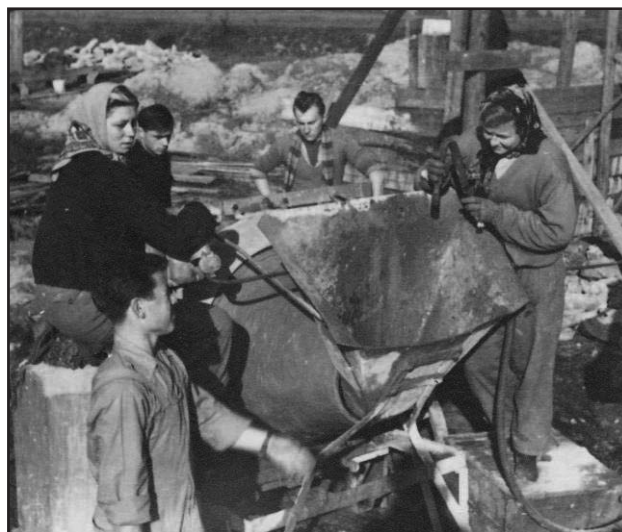
Betonáři: Tomas, Ožďanová, Prouza, Felkl a Hanušová
