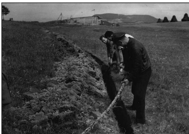
Kabel ukládají Plecháč, König a C. Šimek. Hloubka rýhy byla tak na dva „sakováky“, což se později ukázalo jako málo a při obnově letiště musel být několikrát přerušeny kabel vyměněn. F: Lyer
