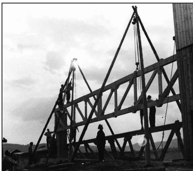
Zvedání hlavních nosníků na druhou půlku hangaru.
